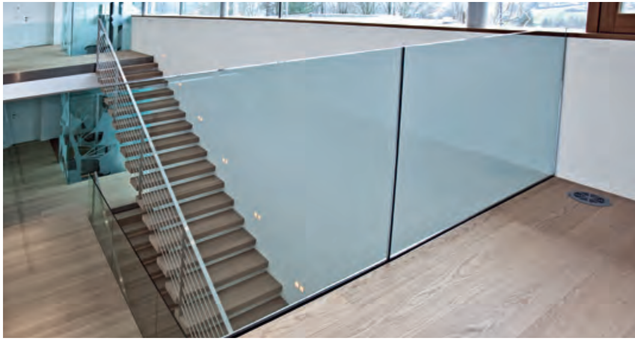
Kragarmtreppe aus dem gleichen Holz wie der Boden: Eiche Aussee.
