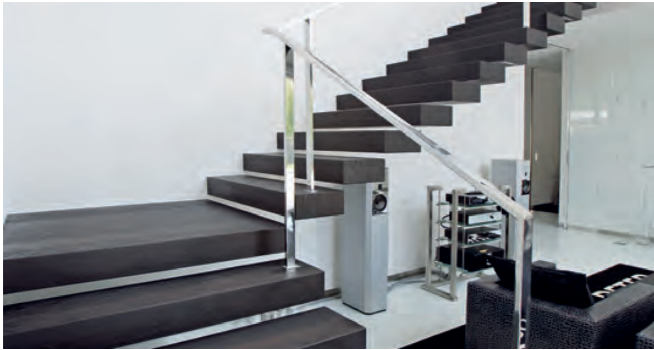
Kragarmtreppe aus dem gleichen Holz wie der Boden: Terra Eiche Romano, dunkel und elegant.
